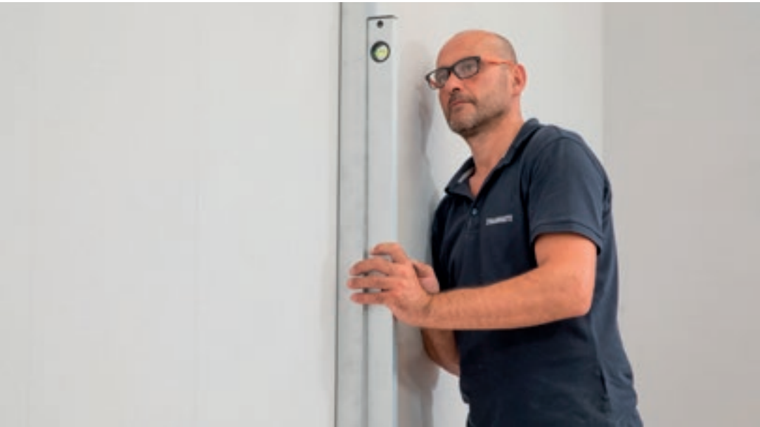
1. Prima di procedere con la posa verificare che il fondo sia perfettamente planare, asciutto e pulito. Utilizzare i collanti descritti miscelati in base alle specifiche indicate nella scheda tecnica del collante prescelto. Si raccomanda l'utilizzo di adesivi cementizi ad alte prestazioni in classe C2 o superiore. Si suggerisce l'utilizzo di adesivi a scivolamento verticale nullo (caratteristica identificata dalla lettera T).
