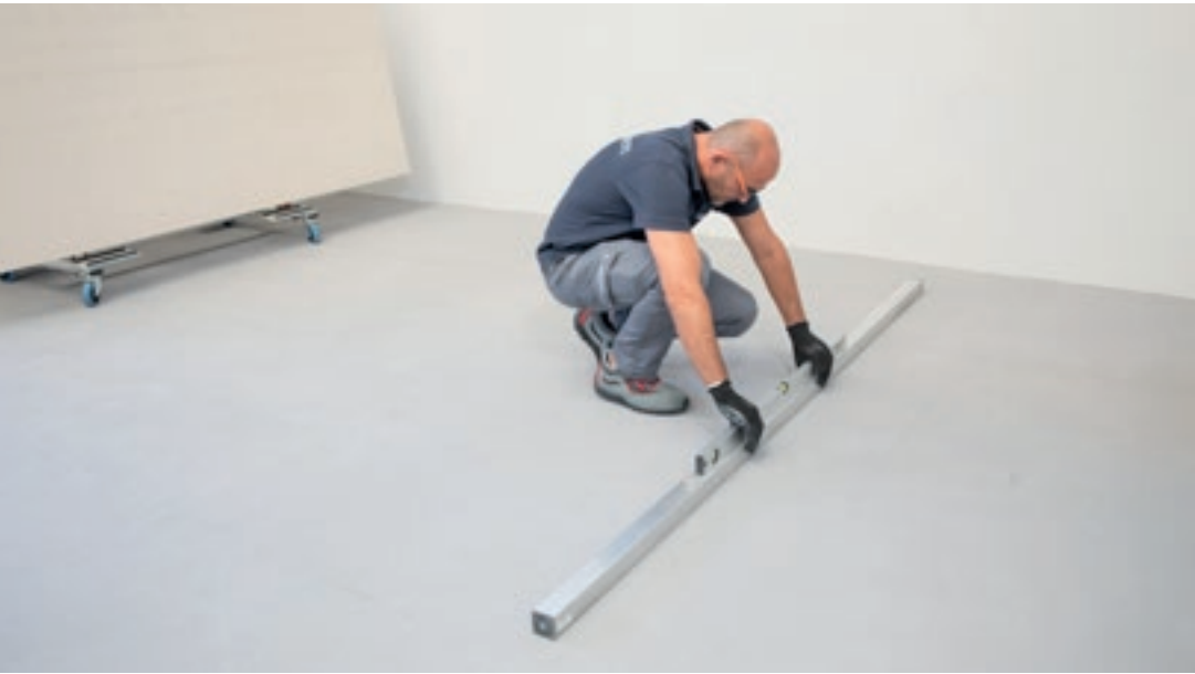
1. Prima di procedere con la posa verificare che il fondo sia perfettamente planare, asciutto e pulito. Utilizzare i collanti descritti miscelati in base alle specifiche indicate nella scheda tecnica del collante prescelto. Si raccomanda l'utilizzo di adesivi cementizi ad alte prestazioni in classe C2 o superiore.
