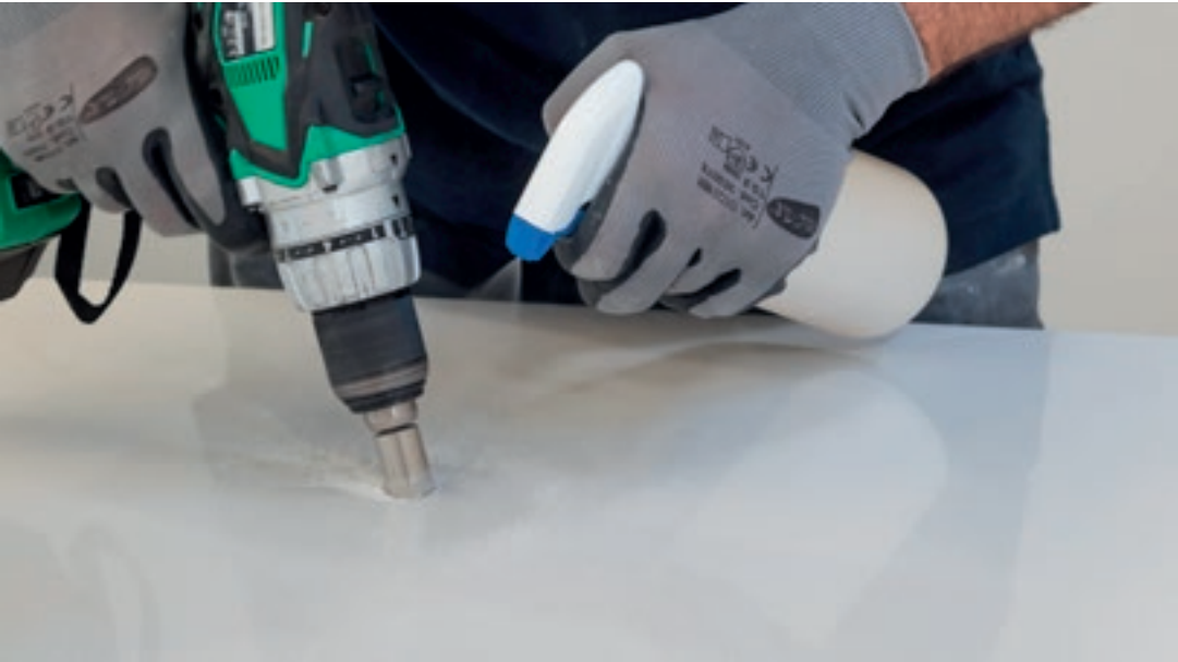
2. Eseguire il foro con un'angolazione di 75°-85° e penetrare nella lastra per circa 1-2 mm di profondità.
