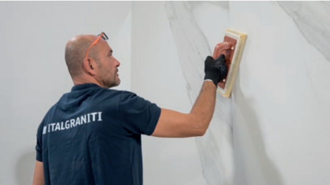
8. Si raccomanda di alternare e orientare i pezzi in modo da creare una distribuzione naturale del disegno e delle venature. Si consiglia una stuccatura in tinta con il prodotto, mantenendo una fuga minima di 2 mm (come prevede la normativa europea).
