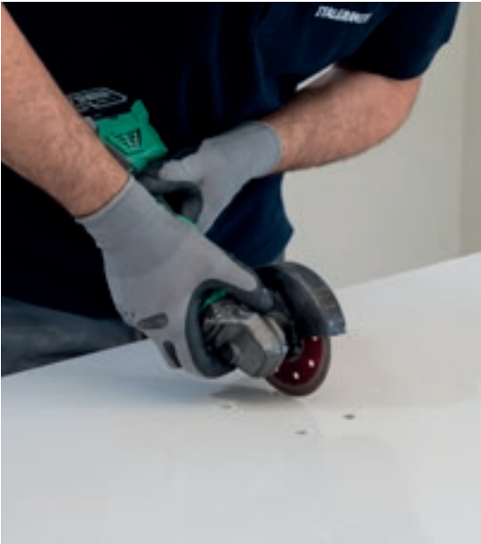
3. Congiungere il foro con l'estremità della lastra attraverso apposita smerigliatrice angolare equipaggiata con disco diamantato.
