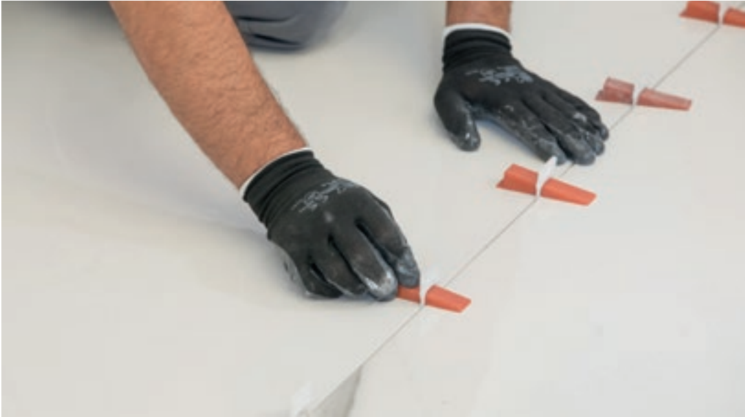
7. Come per tutti i formati di grandi dimensioni, si suggerisce l'utilizzo dei distanziatori autolivellanti (levellers) per ottenere un risultato estetico ottimale.
