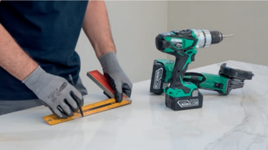
1. Tracciatura: segnare sulla lastra la porzione da tagliare.
