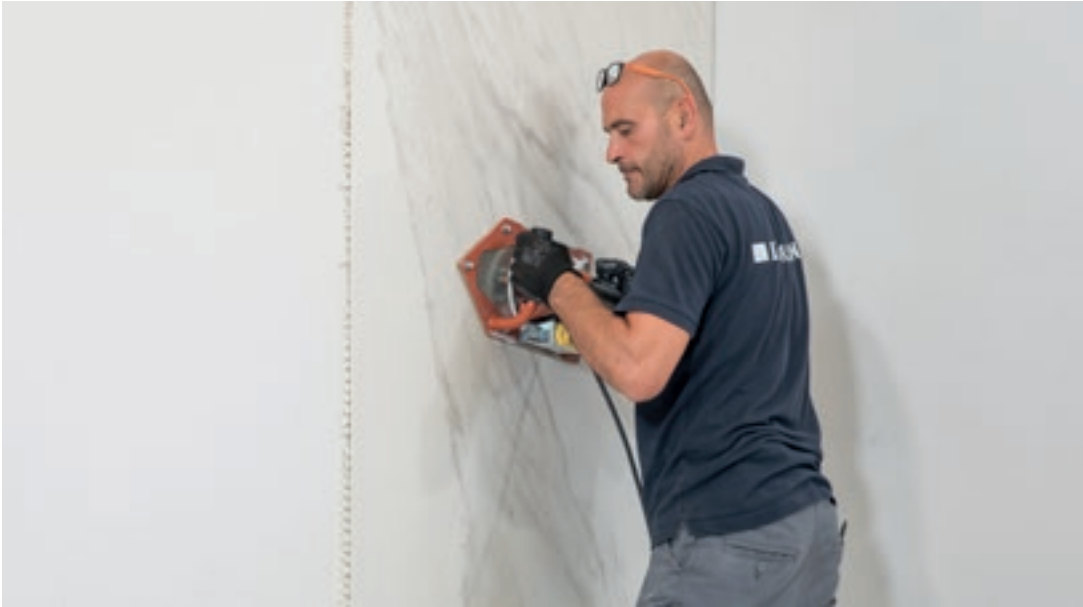
6. Con l'apposito battitore a vibrazione (o in alternativa con frattazzo in gomma antirimbazzo) assicurarsi che l'incollaggio della lastra avvenga in modo uniforme. Battere dal centro verso i bordi per favorire l'eliminazione di eventuali sacche d'aria tra la lastra, il collante e il fondo di posa. Non utilizzare martelli o utensili non idonei.
