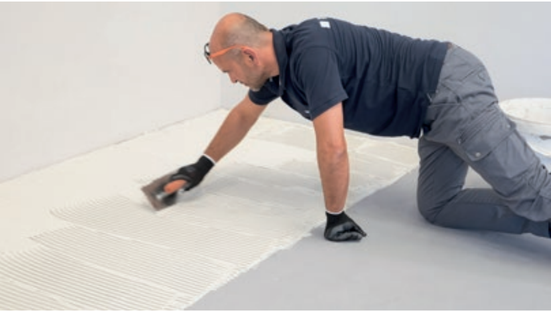
2. Distribuire la colla sul pavimento utilizzando l'apposita spatola a denti inclinati (10x10 mm), stendere il collante superando di 5/10 cm la superficie della lastra.
