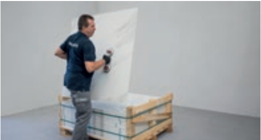
Biventose o monoventose con vuotometro per formati fino a 120x120 cm.
