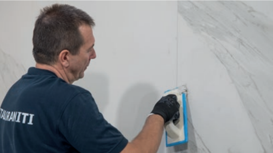
8. Si raccomanda di alternare e orientare i pezzi in modo da creare una distribuzione naturale del disegno e delle venature. Si consiglia una stuccatura in tinta con il prodotto, mantenendo una fuga minima di 2 mm (come prevede la normativa europea).
