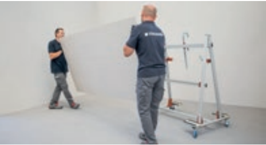
Carrello di movimentazione predisposto per eseguire la stesura della colla sul retro lastra.
