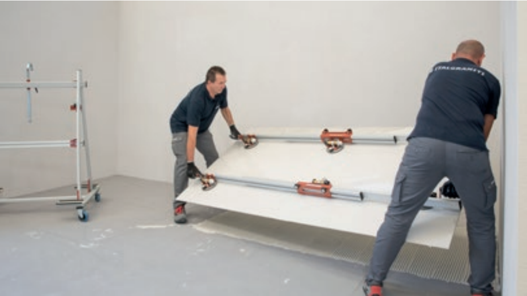
5. Mediante il telaio di movimentazione con ventose di sicurezza accompagnare la lastra in posizione e posarla.
