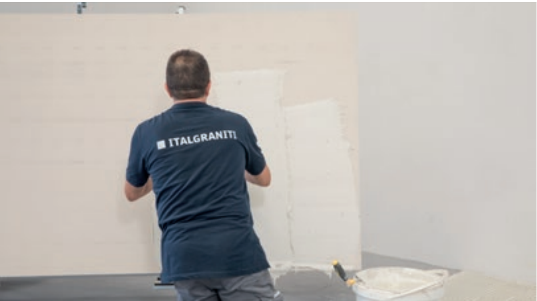
3. Una volta distribuito il collante accertarsi che nell'ultima stesura l'andamento delle righe sia sempre e solo in un unico verso (per una stesura a regola d'arte le righe dovrebbero essere in linea con il lato corto della lastra), evitare gli incroci che non favoriscono l'espulsione dell'aria dal centro della lastra.
