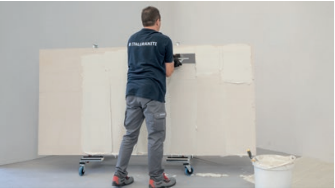
4. Stendere il collante sul retro della lastra utilizzando l'apposita spatola a denti quadri (3x3 mm) e accertarsi che le righe dell'ultime stesura siano nella stessa direzione di quelle della spalmatura della lastra. Durante la fase di stesura, la lastra dovrà essere in posizione verticale e fissata al telaio di movimentazione con ventose di sicurezza posate sopra al carrello per il trasporto con ruote.
