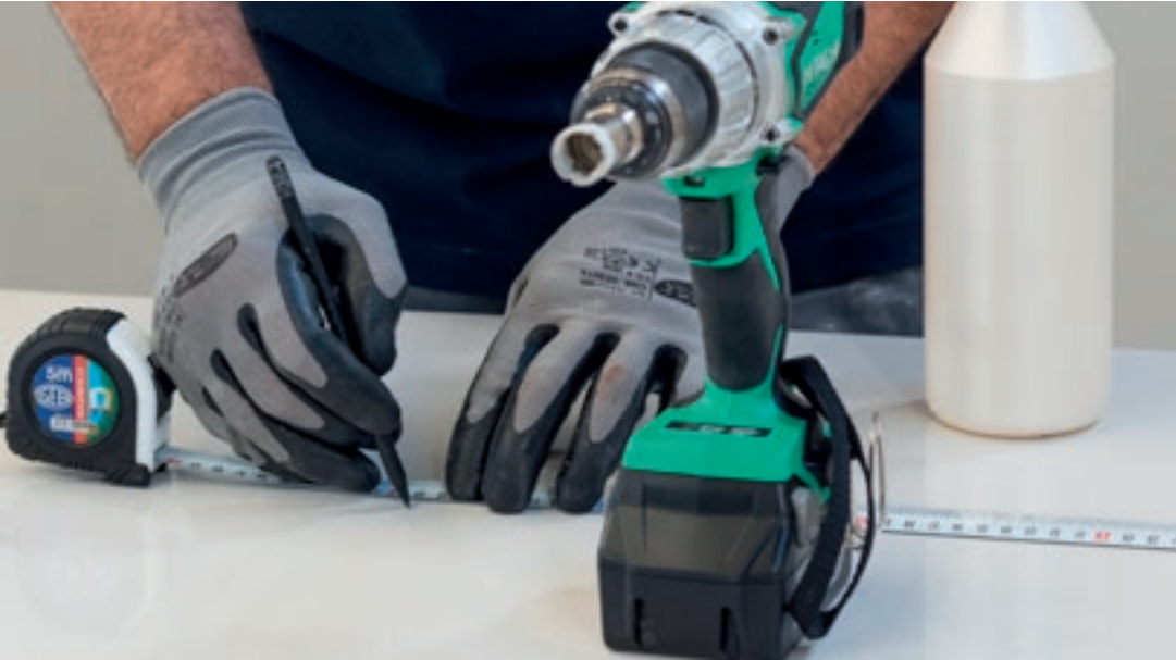
1. Adagiare la lastra Mega su un banco da lavoro o un supporto compatto e non scivoloso come legno o cemento. Bagnare con acqua l'area dove verrà praticato il foro.
