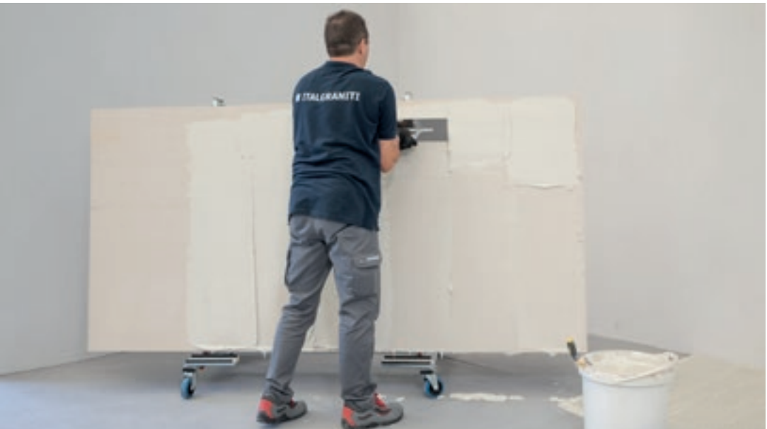
4. Stendere il collante sul retro della lastra utilizzando l'apposita spatola a denti quadri (3x3 mm) e accertarsi che le righe dell'ultima stesura siano nella stessa direzione di quelle della spalmatura della lastra. Durante la fase di stesura, la lastra dovrà essere in posizione verticale e fissata al telaio di movimentazione con ventose di sicurezza posate sopra al carrello per il trasporto con ruote.
