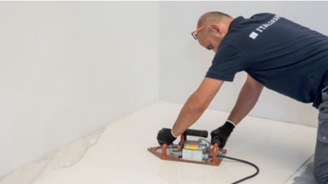
6. Con l'apposito battitore a vibrazione (o in alternativa con frattazzo in gomma antirimbalzo) assicurarsi che l'incollaggio della lastra avvenga in modo uniforme. Battere dal centro verso i bordi per favorire l'eliminazione di eventuali sacche d'aria tra la lastra, il collante e il fondo di posa. Non utilizzare martelli o utensili non idonei.
