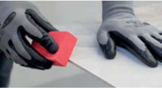
Tamponi diamantati per rifinire i bordi dopo l'esecuzione dei tagli.
