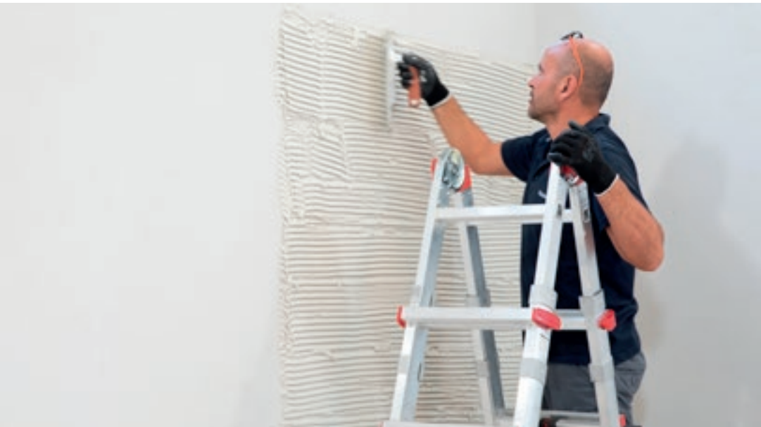
2. Distribuire la colla sulla parete utilizzando l'apposita spatola a denti inclinati (10x10 mm), stendere il collante superando di 5/10 cm la superficie della lastra.
