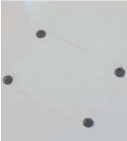
2. Foro: attraverso i foretti diamantati eseguire il foro in corrispondenza del punto di congiunzione delle linee tracciate sulla lastra (fori tondi di circonferenza 7/8 mm).
