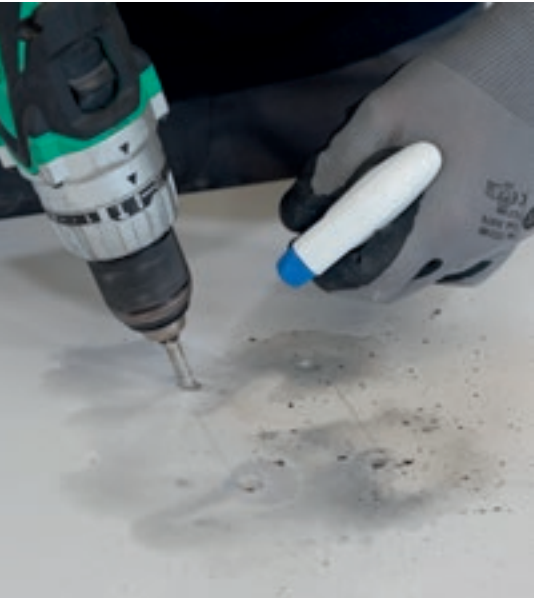
2. Foro: attraverso i foretti diamantati eseguire il foro in corrispondenza del punto di congiunzione delle linee tracciate sulla lastra (fori tondi di circonferenza 7/8 mm).
