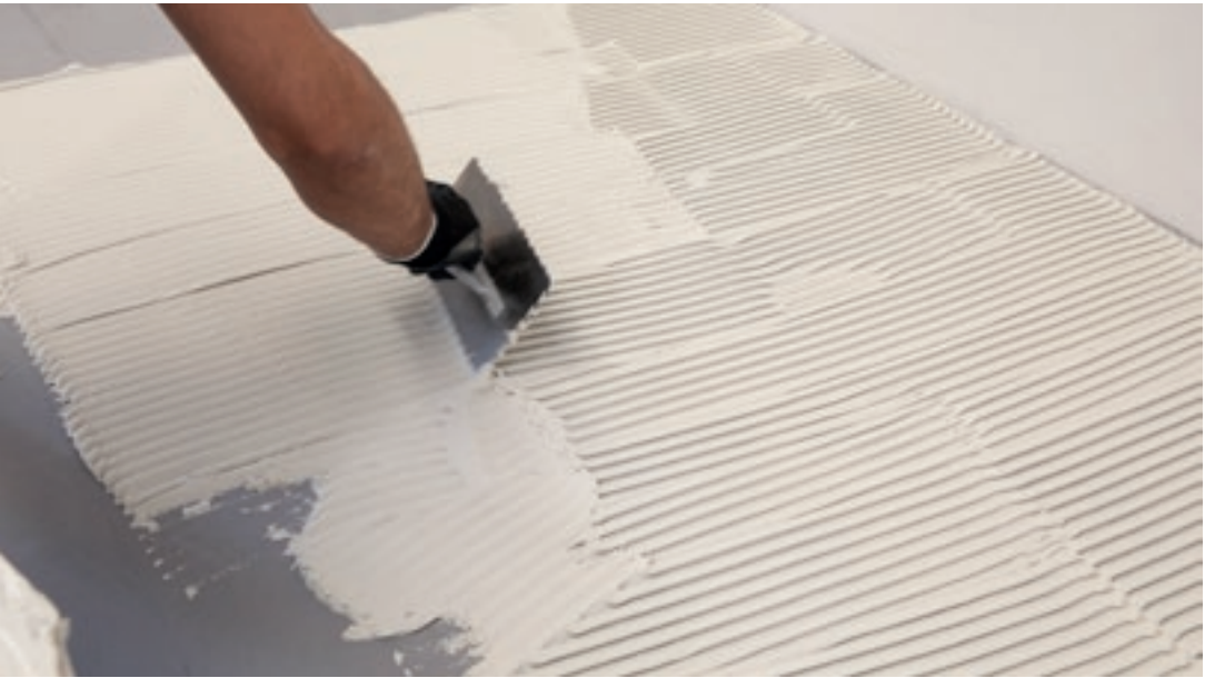
3. Una volta distribuito il collante accertarsi che nell'ultima stesura l'andamento delle righe sia sempre e solo in un unico verso per una stesura a regola d'arte le righe dovrebbero essere in linea con il lato corto della lastra), evitare gli incroci che non favoriscono l'espulsione dell'aria dal centro della lastra.
